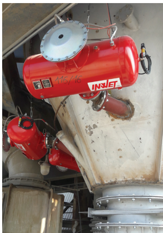
FOT. 3, 4 Pulsatory SYNEX – sztandarowy produkt oferowany przez INWET [ŹRÓDŁO: INWET]
